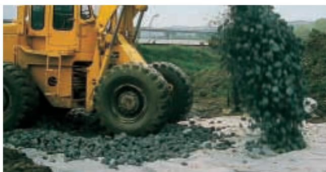
Typar® выдерживает высокие механические нагрузки во время укладки
