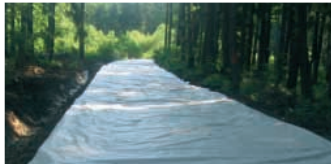
Строительство лесной дороги
