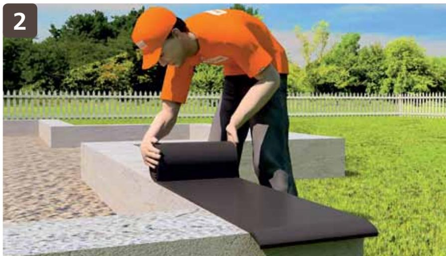
Соединение полос производится с нахлестом не менее 150 мм.
