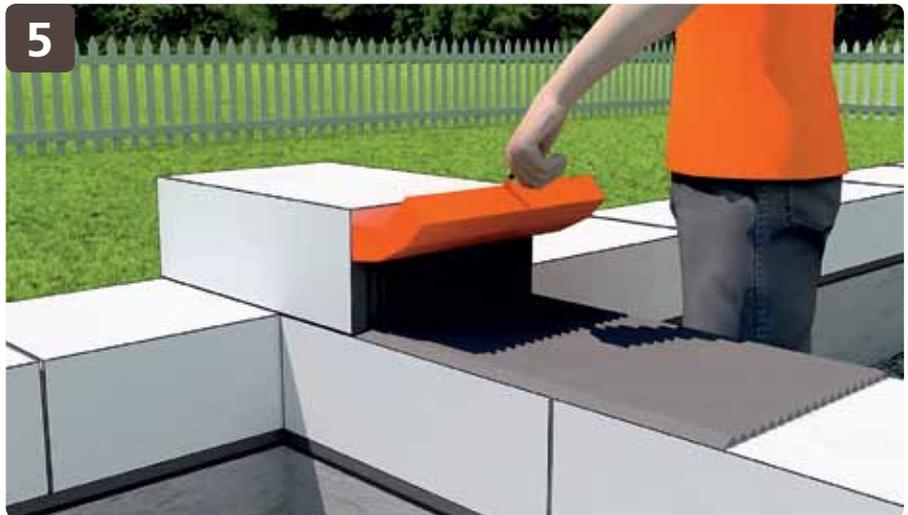
Укладывается очередной блок. Перевязка блоков должна составлять не менее 100 мм.
