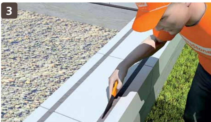
Уложить арматуру. В стенах из блоков AeroStone® рекомендуется использовать арматуру А-III диаметром 8 мм.
