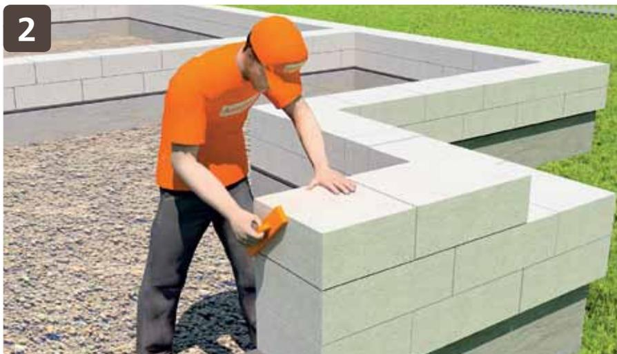
Поверхность блока выравнивают шлифовальной доской или рубанком AeroStone®.
