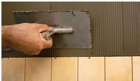
Нанесение **LITOKOL K17** зубчатым шпателем
