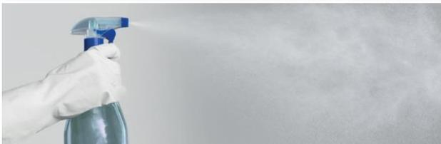
На высохшую гидроизолированную вертикальную поверхность нужно распылить воду из сифона на расстоянии 30-40 мм.
