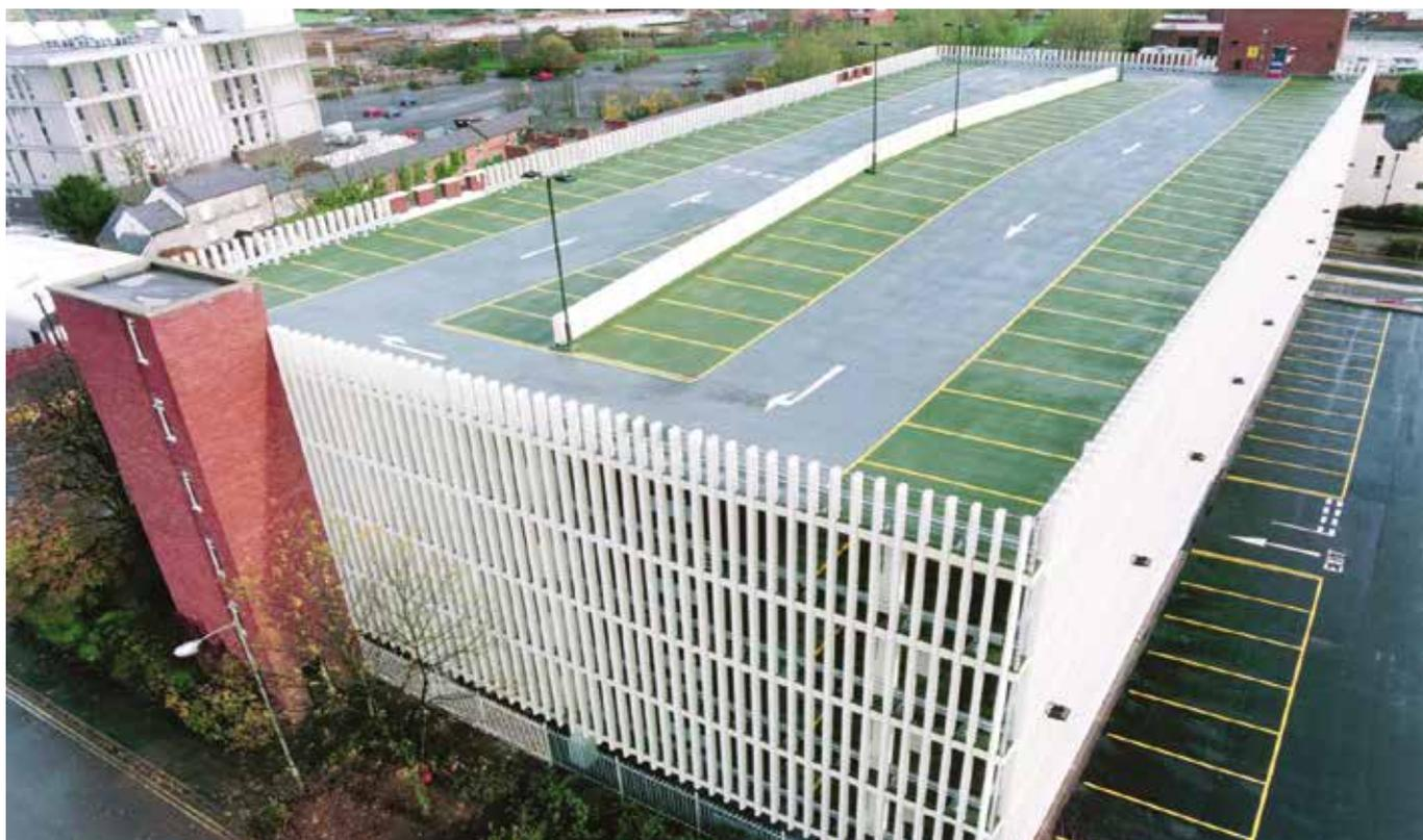
Готовые фасадные панели и напольные плиты, опорные колонны и балки
